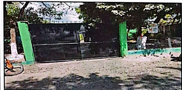
Foto 6: MANTENIMIENTO DE 9 PUERTAS
