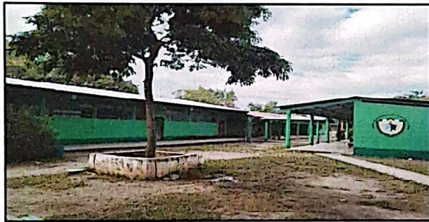
Foto 3: PINTURA EN INTERIOR Y EXTERIOR DE LOS MODULOS, DIRECCIÓN Y AULAS
