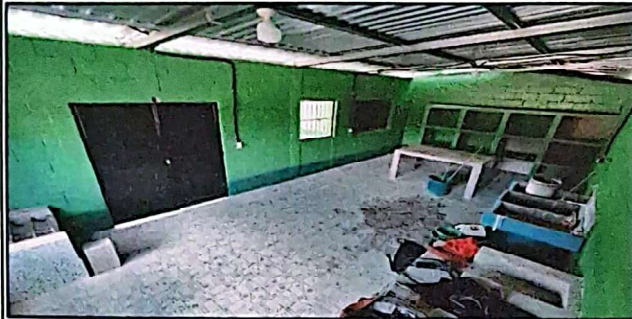
Foto1: REPARACIÓN ÁREA DE COCINA
