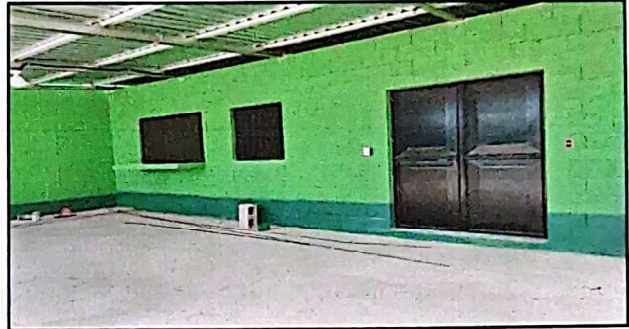
Foto 2: REPARACIÓN ÁREA DE COCINA
