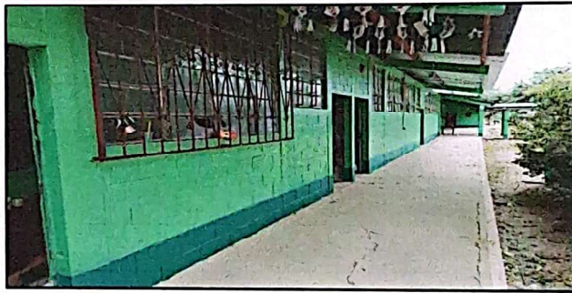
Foto 4: PINTURA EN INTERIOR Y EXTERIOR DE LOS MODULOS, DIRECCIÓN Y AULAS
